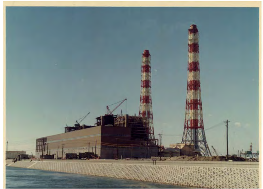
鹿島火力発電所
