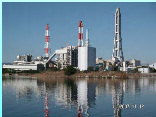
勿来石炭ガス化 実証プラント
