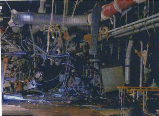
押し流されたタービン機器 (東北電力・原町石炭火力・200万kW)
