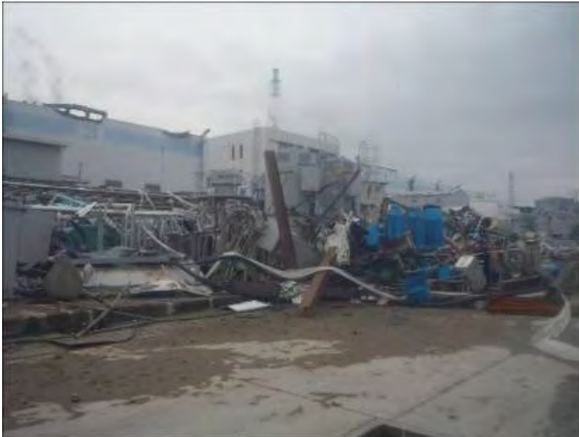
3号機海水ポンプエリア近傍を撮影
