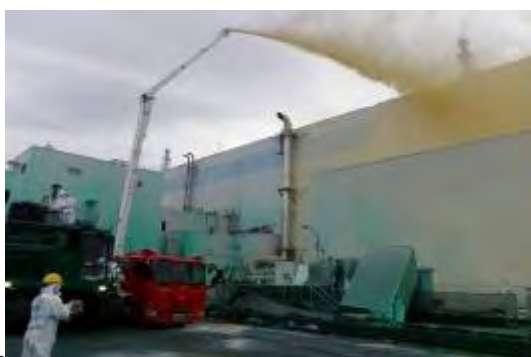
敷地、建屋本体への飛散防止剤散布
