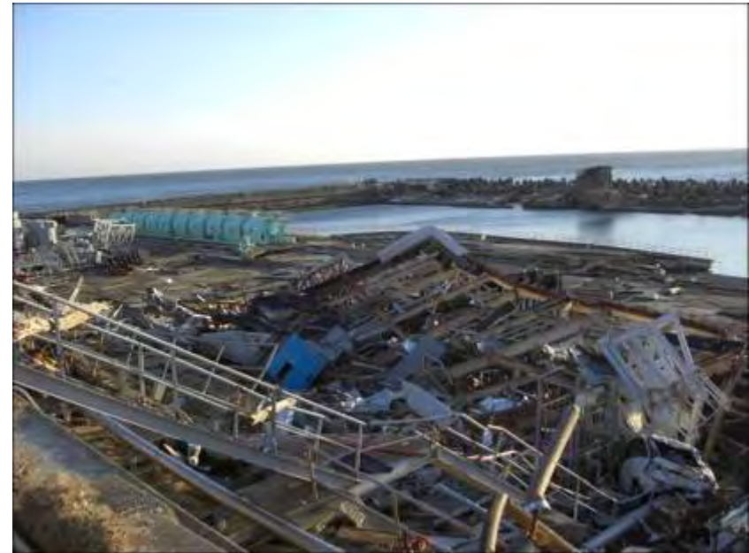
5・6号機取水設備周辺を撮影
