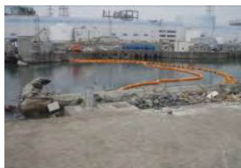
シルトフェンス設置
