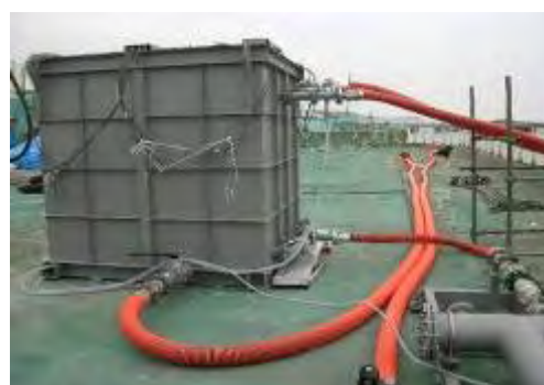
海水循環型浄化装置設置
