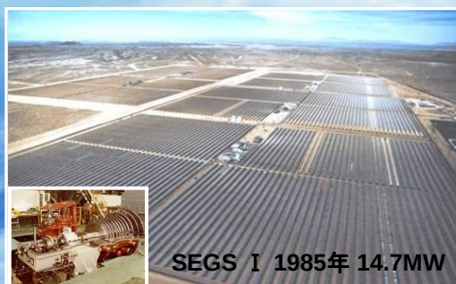
蒸気式太陽熱発電
