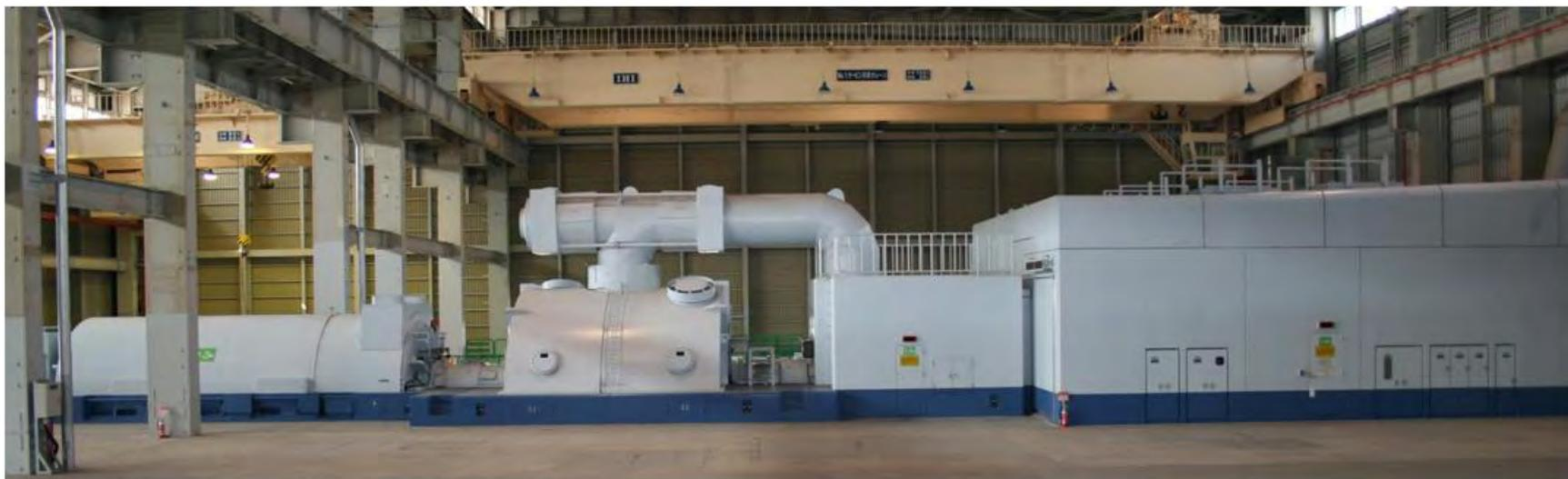
部分負荷運転が少ない現在では一軸（ガスタービン、蒸気タービン各1台が主流）
