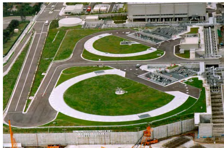
埋設式地下タンク(扇島工場)
