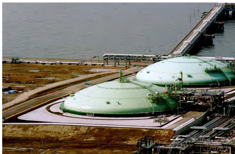
鋼製屋根式地下タンク(袖ヶ浦工場)
