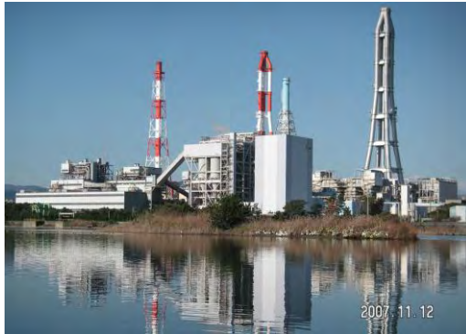
IGCC発電プラント
