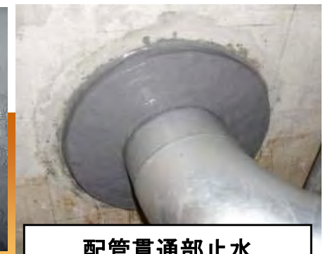
止水処理：重要機器室への浸水防止
