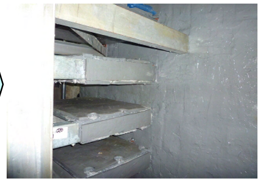
配管、ケーブルの壁貫通部の止水施工例
