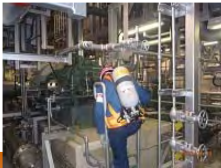
原子炉隔離時冷却系ポンプの 手動操作手順の策定
