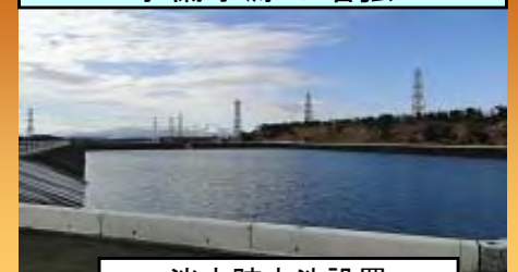
淡水貯水池設置
