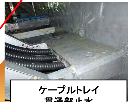
止水処理：重要機器室への浸水防止
