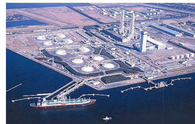
富津LNG基地
