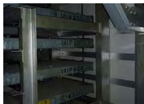
配管、ケーブルの壁貫通部の止水施工例
