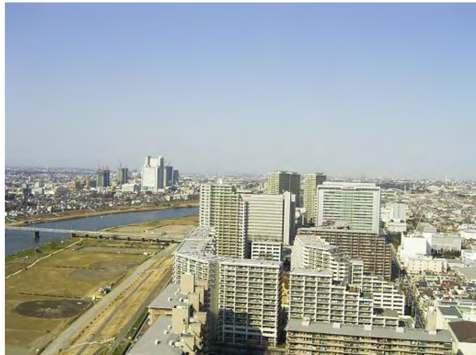
煙突から多摩川上流側を撮影
