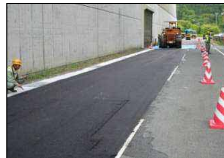
道路舗装アスファルトへ利用
